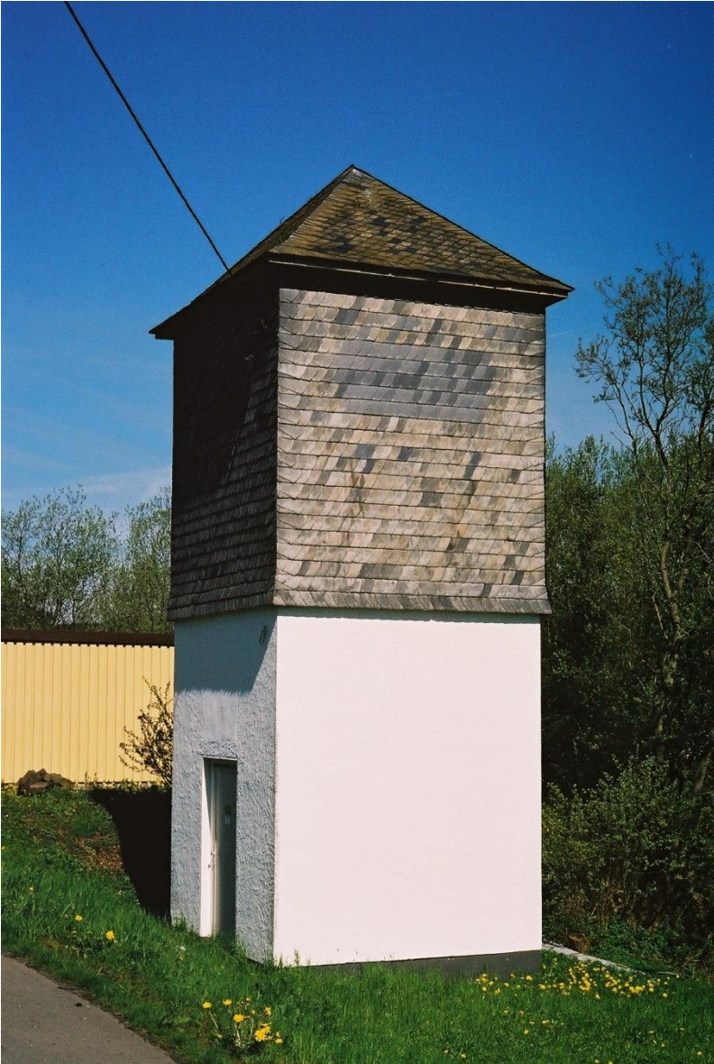
Abb. 47: Das 1922 errichtete Transformatorenhaus in der Thal (Foto: Peter Schneider).
