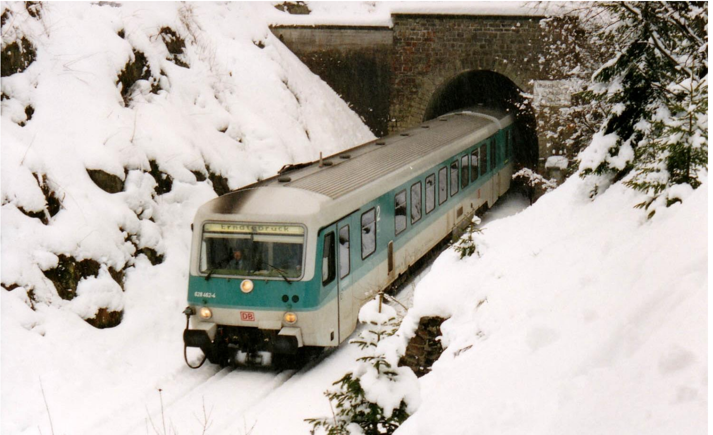
Abb. 46: In der Heege liegt der 321 Meter lange Leimstruther Tunnel (Foto: Peter Schneider).
