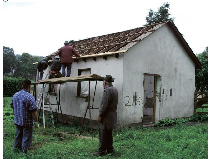
Abb. 37: Sanierung des Heimathäuschen im Jahr 2003 (Foto: Sascha Roth).
